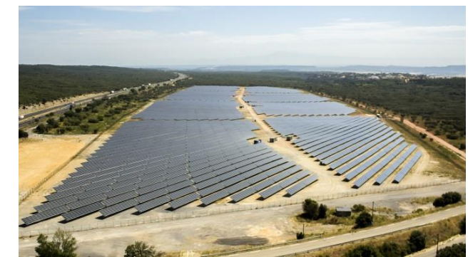
Rochefort du Gard / 11.0 MW
