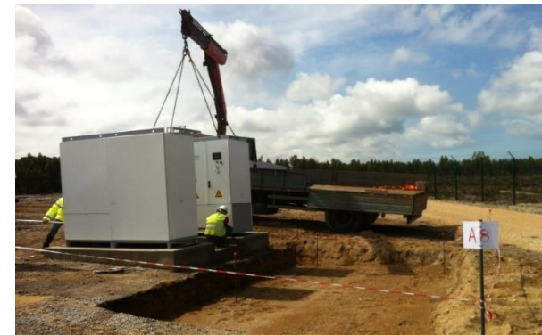
Exemple d'installation de poste de conversion
