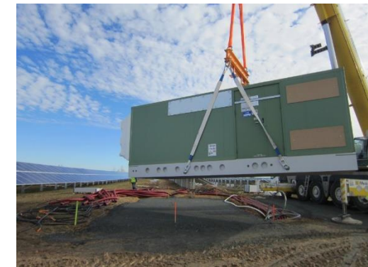
Exemple d'installation de poste de conversion
