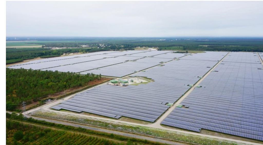
Centrale photovoltaïque de Cestas (33)
