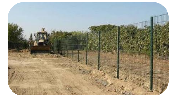
Pose des clôtures (source : Neoen)
