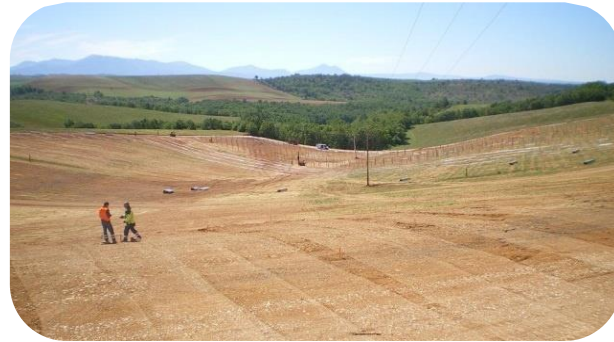
Piquetage (source : Neoen)
