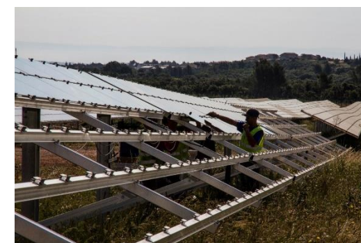
Montage des structures supports (source : NEOEN)
